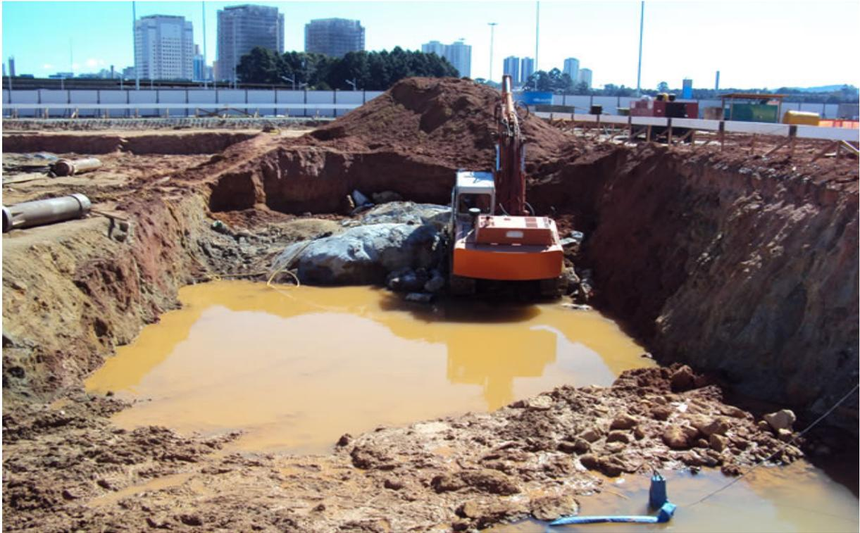
Figura 2.1: Exemplo de problema gerado pela presença de um matacão não-mapeado previamente utilizando geofísica. (Fonte: [www.altaresolucao.com.br](http://www.altaresolucao.com.br))
