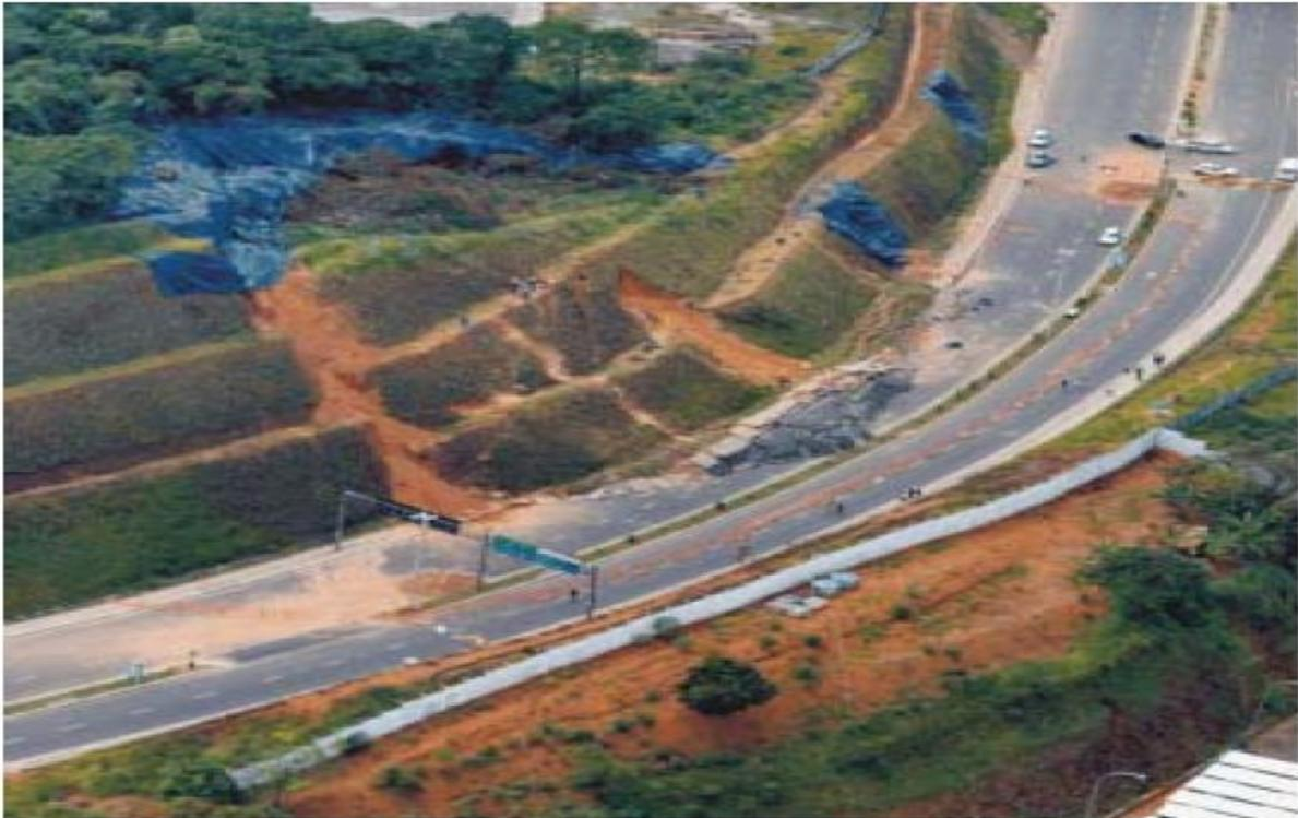
Figura 2.2: Exemplo de problema gerado pela presença de uma falha não-mapeada previamente utilizando geofísica ocorrido em Salvador-Bahia. (Fonte: Informativo do Serviço Geológico do Brasil - CPRM - MME/SGM - Ano 4 - Nº 16 - Edição de junho de 2007)
