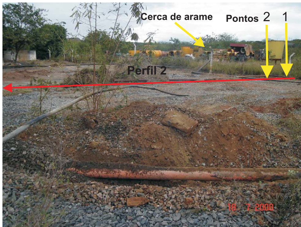
Figura 3.7: Imagem mostrando no início do perfil 2 duas tubulações que correspondem às interferências 1 e 2 do mesmo perfil.
