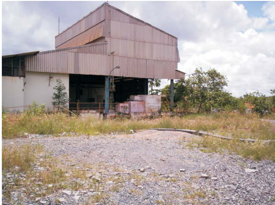
Figura 3.1: Vista lateral da usina de lixiviação, onde se iniciou o levantamento geofísico com o GPR.
